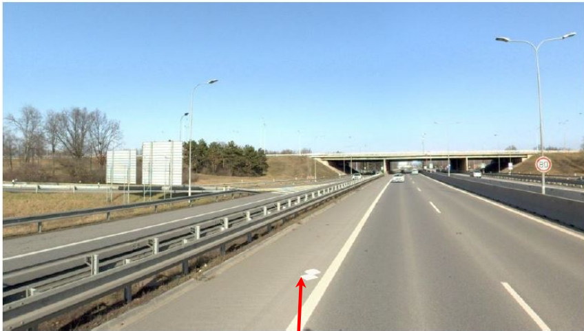
Ukázka provedené signalizace VLB na vozovce
